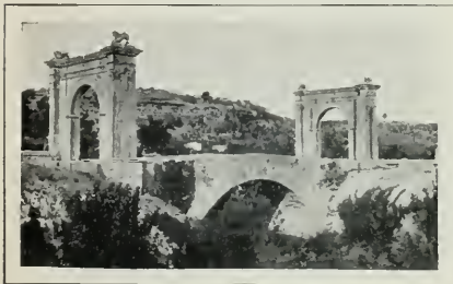
FIG. 5.—BRIDGE OF SAINT-CHAMAS. (Photo. Gouzy.)
