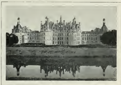
FIG. 270.—CHATEAU DE CHAMBORD. (Photo. Monuments Historiques. )
